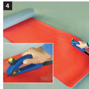
4 Für einen geraden Schnitt bei PVC Folie (Membranen) Pour la découpe linéaire d'une membrane PVC Cut through roofing membrane (plastic board)
