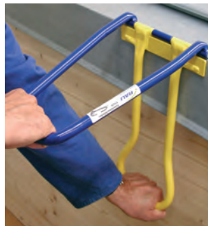
TSCH beim Schließen von Ortgangblechen Pliouse à larmier coudée sertissant les tôles TSCH fitting verge
