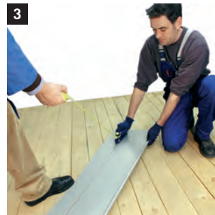
3 Längsteilung an Bandblechen vor Ort Pour ajuster la largeur des longues tôles sur vos chantiers Lengthening cutting at broad strips locally
