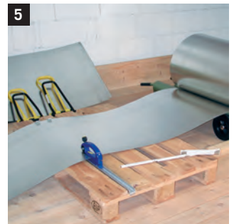
5 Mit einfachen Hilfsmitteln (Europalette) lässt sich die Arbeit auf der Baustelle erleichtern Une simple palette „EUROPE“ vous facilite son utilisation sur chantier With simple aids (euro pallet) the work on the building site can be facilitated
